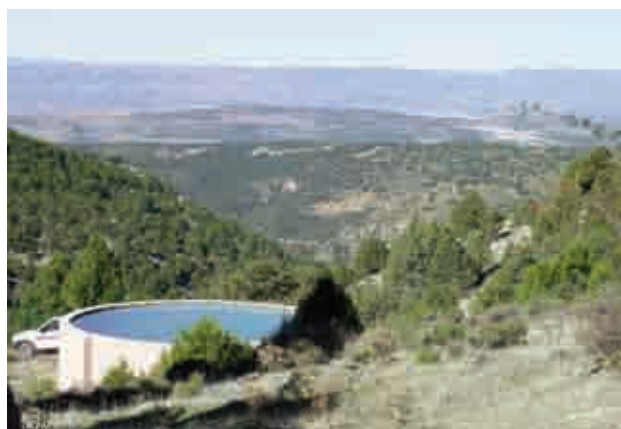
Photo 13 : Equipements anti-incendie dans le Parc naturel de Puebla de San Miguel (Région de Valence).
