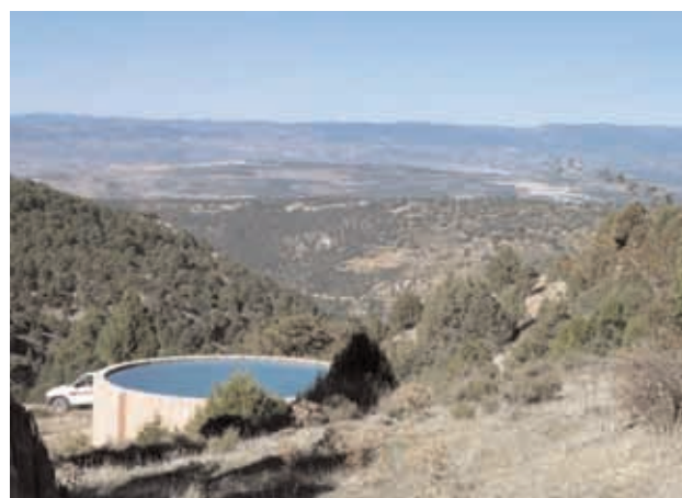
Photo 6 : Réservoir d'eau installé dans le cadre du dispositif local de lutte contre les incendies.
