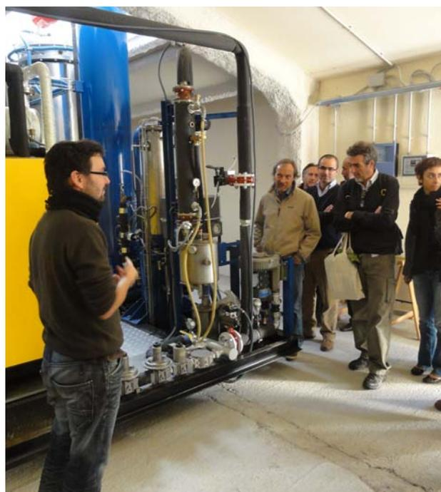
Photo 11 : Unité de micro-cogénération (gazification de la biomasse et production d'électricité).
